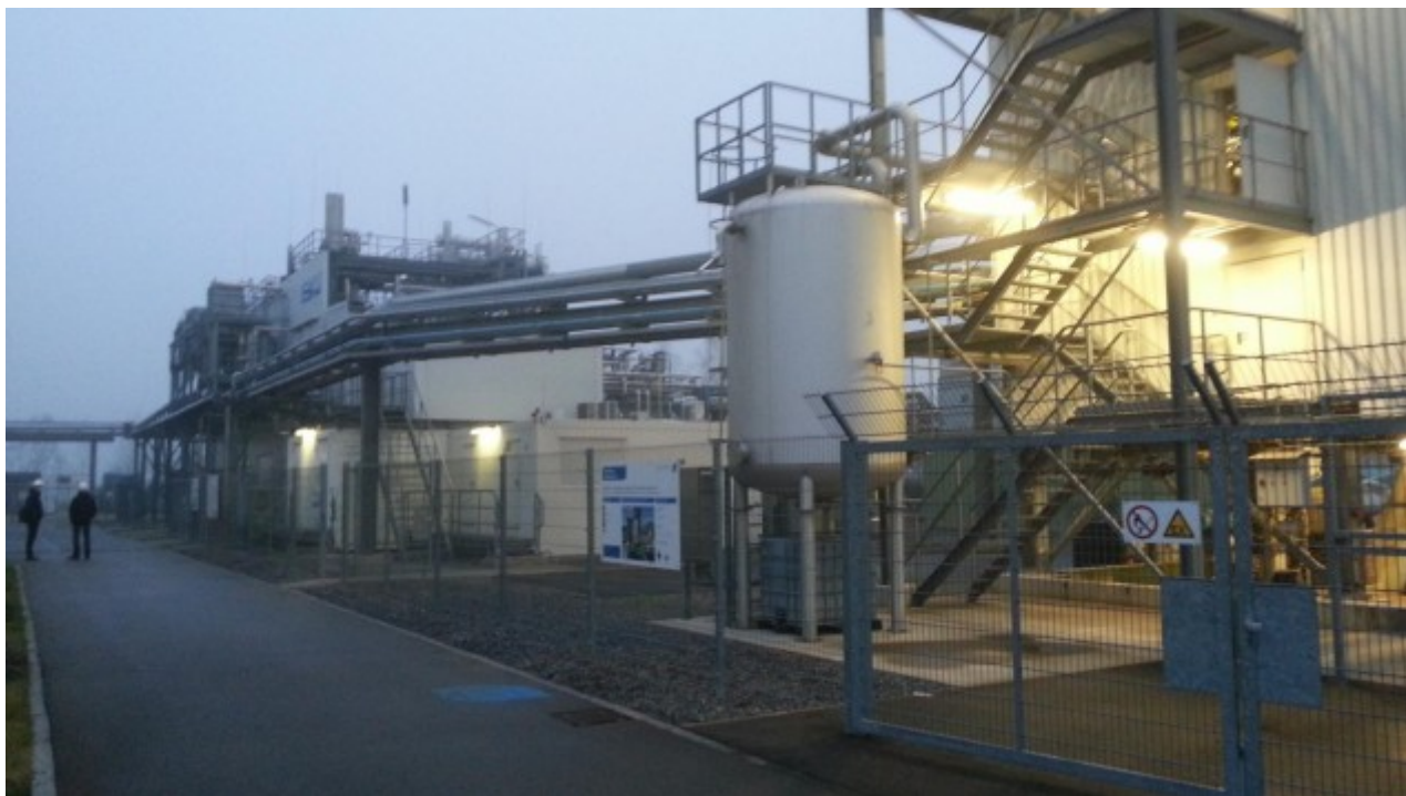
In Freiberg hängt das eine mit dem anderen zusammen: vorn rechts die Schlackebadvergasungsanlage zur Wasserstofferzeugung, hinten links die Anlage zur Erzeugung synthetischen Benzins der Firma CAC. (Deutschlandradio / Frank Drescher)
