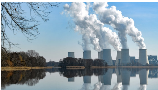
Das Braunkohlekraftwerk Jänschwalde verbrennt derzeit etwa 400.000 Tonnen aus Restmüll gepresste Ersatzbrennstoffe.
