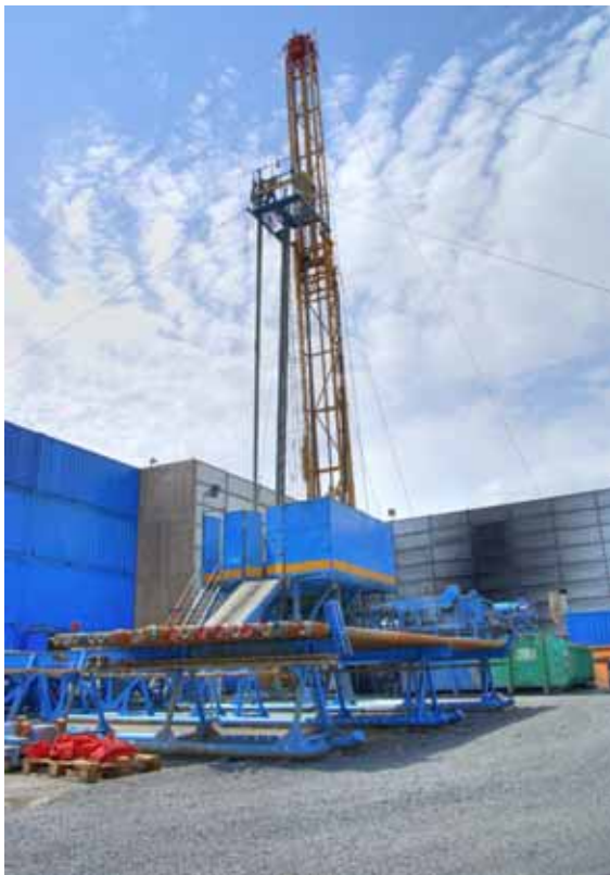
Bild 8: Bohranlage IDECO SBS auf der Bohrung Erlenbach2, Arnsberg
