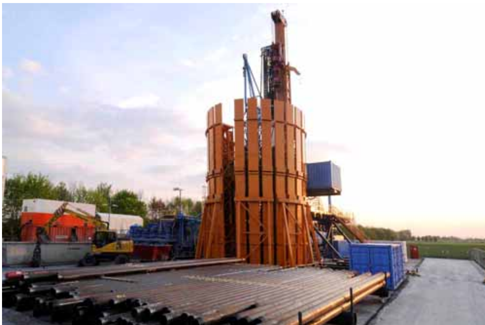
Bild 10: Bohranlage Drillmec HH300 City Rig auf der Lokation Aschheim
