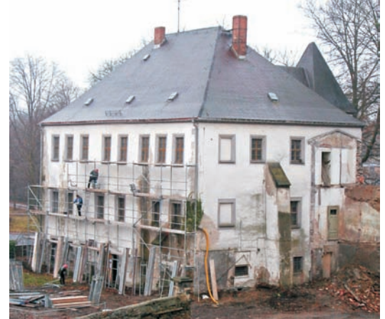
Das Krügerhaus zu Beginn der Bauarbeiten.
