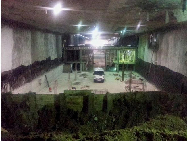
Abbildung 2: Baustelle Metrohaltestelle "Vitoshka"
