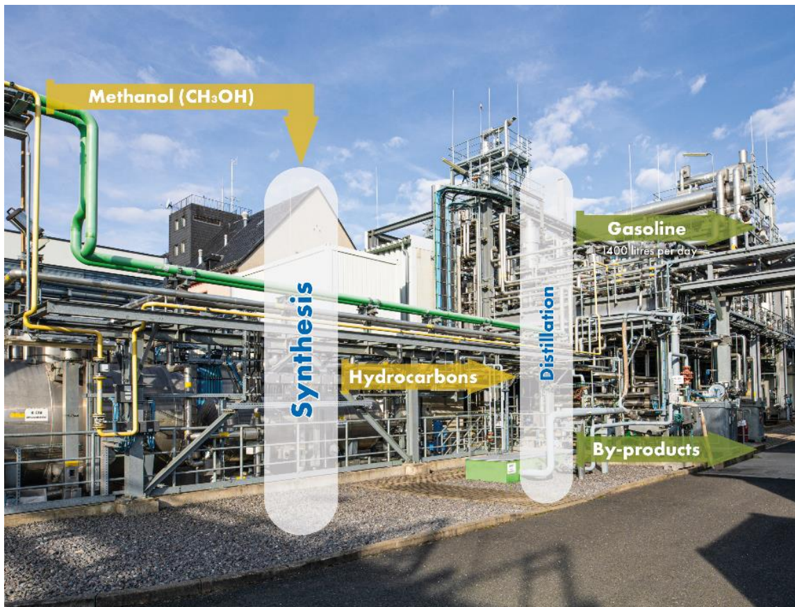
Methanol-to-Gasoline-Prozess in der Benzinsynthese-Großversuchsanlage
