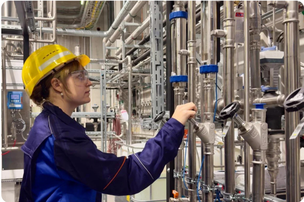
Doktorandin Viktoriia Kison prüft den Kühlkreis für den Plasmabrenner. Foto: IEC
