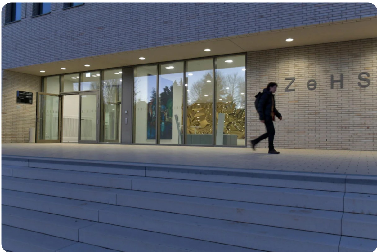
Das Zentrum für effiziente Hochtemperatur-Stoffumwandlung ist 2021 an der Winklerstraße in Freiberg eröffnet worden. Bild: Eckardt Mildner
