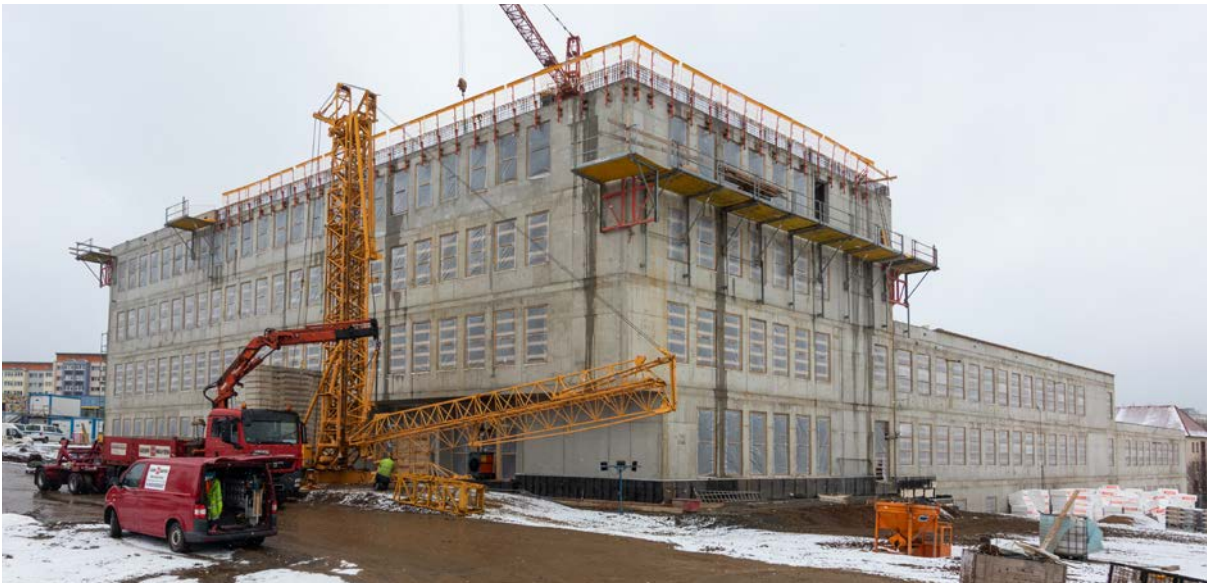
Abbildung 4: Rohbau des ZeHS im Februar 2019 mit fast vollendetem Kopfbau
