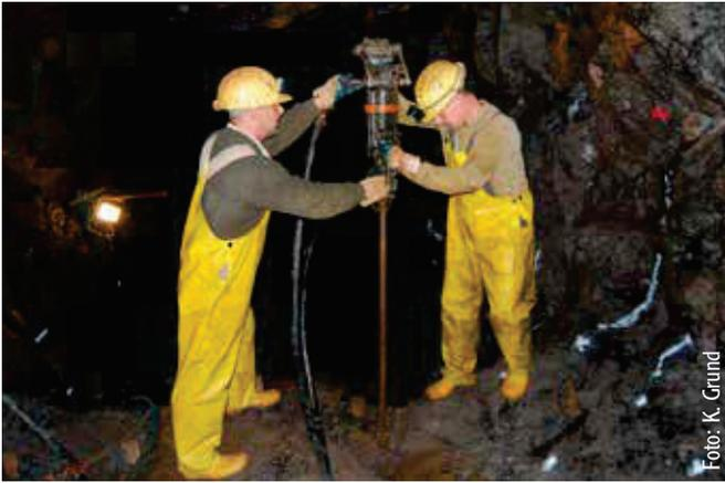
Abb. 10: Mitarbeiter des FLB bei Aufführungsarbeiten für den neuen Sprengraum.
