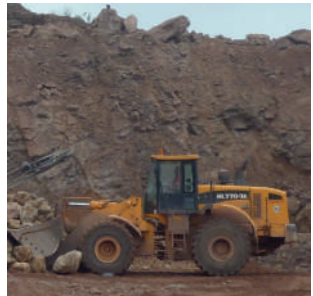
Radlader im Festgesteinstagebau
