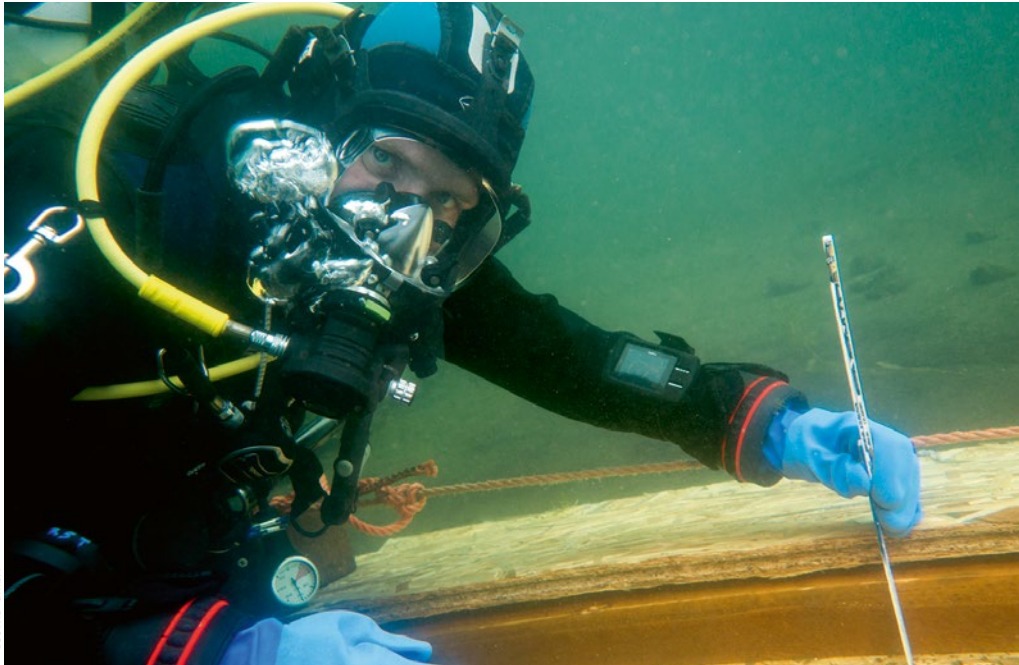
Bild 3: Handnahe Prüfung im Rahmen der Bauüberwachung durch SD
