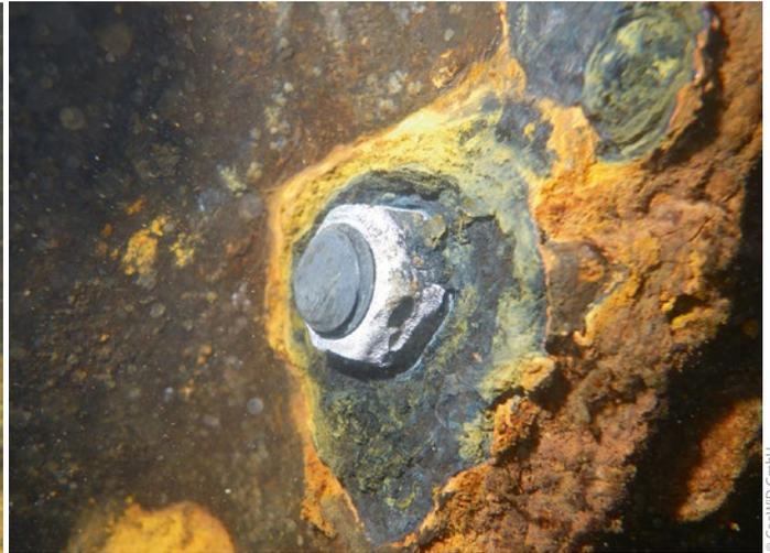
**Bild 3:** Handnahe Untersuchung von Stahlbauteilen: (l.) Schadenszustand vor der Reinigung, (r.) identisches Bauteil wie in A, jedoch nach gezielter Reinigung – deutlicher Substanzverlust und Korrosionsschäden erkennbar
