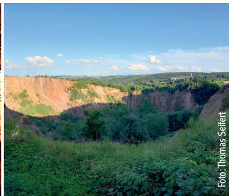
Abb. 4-1: Pinge im Bereich der Sn-W-Li-Lagerstätte Altenberg (Blick von Nord nach Süd); Durchmesser ca. 400 m, Tiefe: ca. 160 m, Fläche: ca. 12 ha; Resultat des großen Pingenbruchs 1620 und des folgenden Bergbaus bis 1991. Im Hintergrund der Arno-Lippmann-Schacht vom VEB Zinnerzbetrieb Altenberg (Hauptförderschacht von 1963 bis 1991 mit einer Förderung von 0,5 bis 1 Mio. t Sn-Erz pro Jahr).
