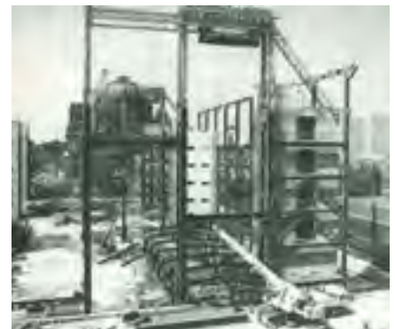
Abb. 3: Baufoto „Palast der Republik“ von Südost, Bodenmontage des ersten 87-Meter-Dachbinders, die Hubkonstruktion ist bereits aufgesetzt (aus: Büttner/Hampe, 416)
