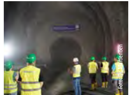
Abb. 7: Montagehalle und Startpunkt für eine der Tunnelbohrmaschinen
