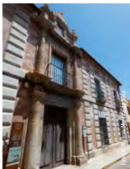
Abb. 3: Gebäude der Bergakademie Almadén im aktuellen Zustand.
