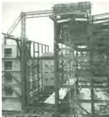
Abb. 5: Baufoto „Palast der Republik“ von Südost, ein Dachbinder ist im Aufsetzen befindlich, der folgende wird vor dem Hub mit Dachplatten belegt (aus: Büttner/Hampe, 417)
