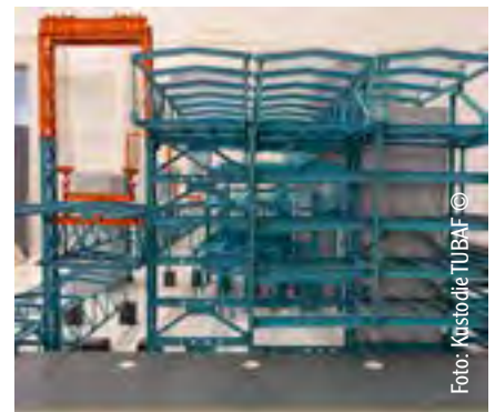
Abb. 4: Modell „Palast der Republik“, M 1:100, Hebung des vierten Dachbinders, der auch im Modell frei an der Verrollbühne schwebt
