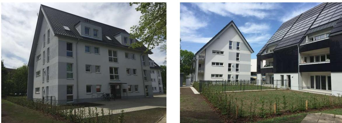
**Abb. 1.1:** Hochgradig solar versorgte Mehrfamilienhäuser in Cottbus (Bauherr: eg Wohnen 1902, GU: Helma AG), links: Nord-Ansicht, rechts: Süd-Ost-Ansicht mit Solarthermie- und PV-Modulen.
