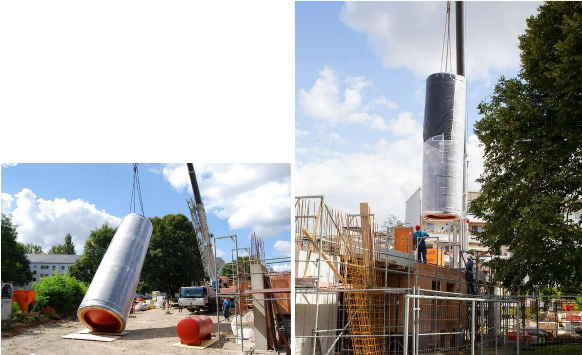
**Abb. D.1:** Einbau eines Groß-Wärmespeichers in ein Sonnenhaus
