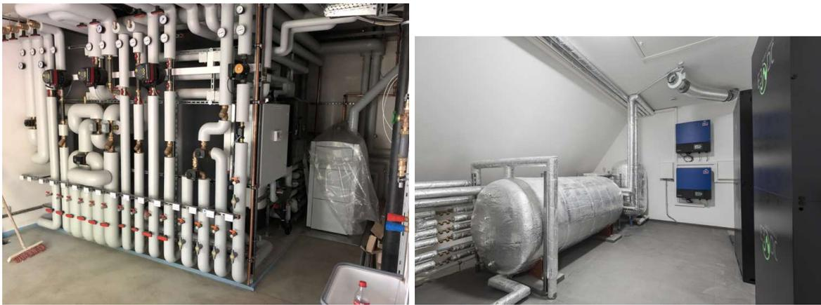
**Abb. D.2:** Einblick in die 2 Technikräume der Mehrfamiliensohnenhäuser von Helma, links: unterer Technikraum mit Verrohrung, Großwärmespeicher (dahinter) und Zusatzwärmequelle (Gasbrennwerttherme), rechts: oberer Technikraum mit Speicherausdehnungsgefäß, PV-WEchselrichter (an der hinteren Wand) und Li-Ion-Akku-Speicher von E3DC (rechts)
