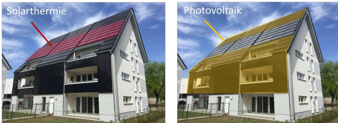
**Abb. 5.1:** Ansicht eines MFH-Sonnenhauses in Cottbus mit markierten Solarthermie- (links, weinrot) und Photovoltaik-Dach- und Fassadenflächen (rechts, gelb)
