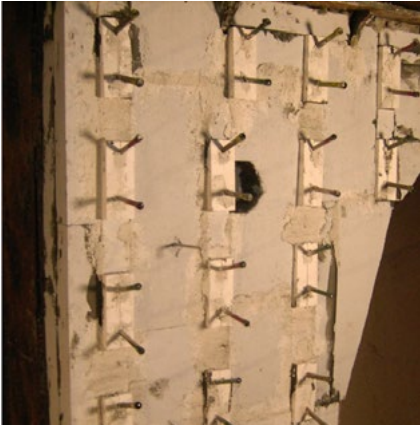
Abbildung 8: SILCAL 1100-Wärmedämmung mit Stahlankern nach dem Einbau im Testfeld (noch ohne Feuerbetonschicht), Stahlanker mit Ankerschutzhülsen umhüllt.
