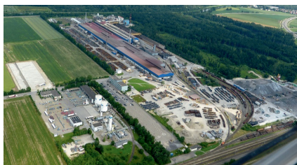
Abb. 2: Luftaufnahme eines Elektrostahlwerkes Quelle: Dr. Hans-Peter Heller (IEST)
