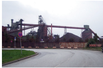
Abb.3: Ansicht einer Direktreduktionsanlage Quelle: Dr. Hans-Peter Heller (IEST)
