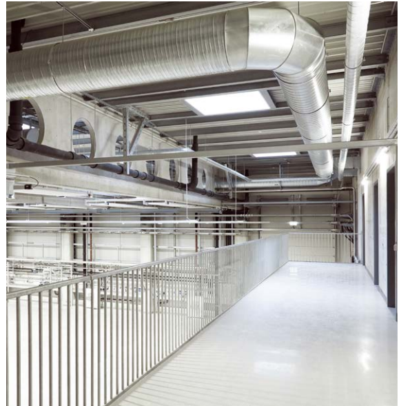
Abbildung 3: Technikumshalle des ZeHS
