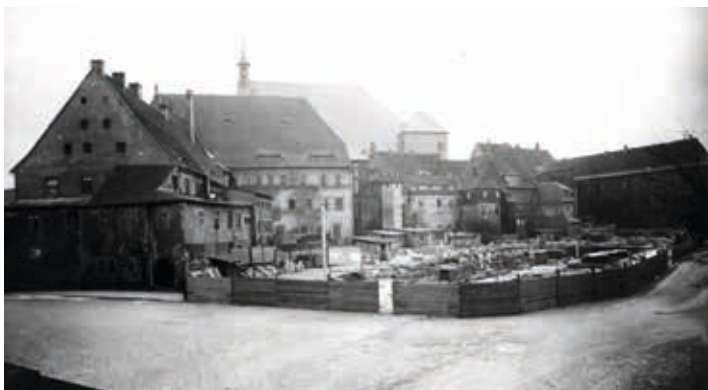
Abb. 2: Bauplatz des neuen Instituts, alter Bauhof in der Brennhausgasse
