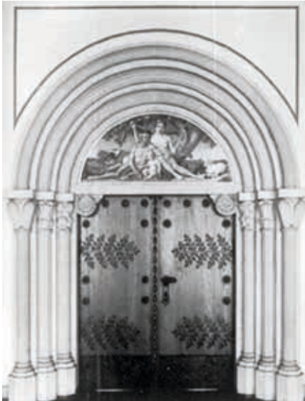
Abb. 8: Cotta-Portal im Werner-Bau, vor 1930, rechts die Vorlage von Cotta (Ausschnitt)
