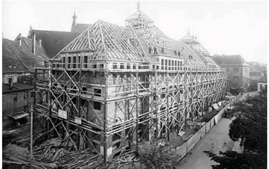
Abb. 3: Stand der Bauarbeiten im Juli 1913
