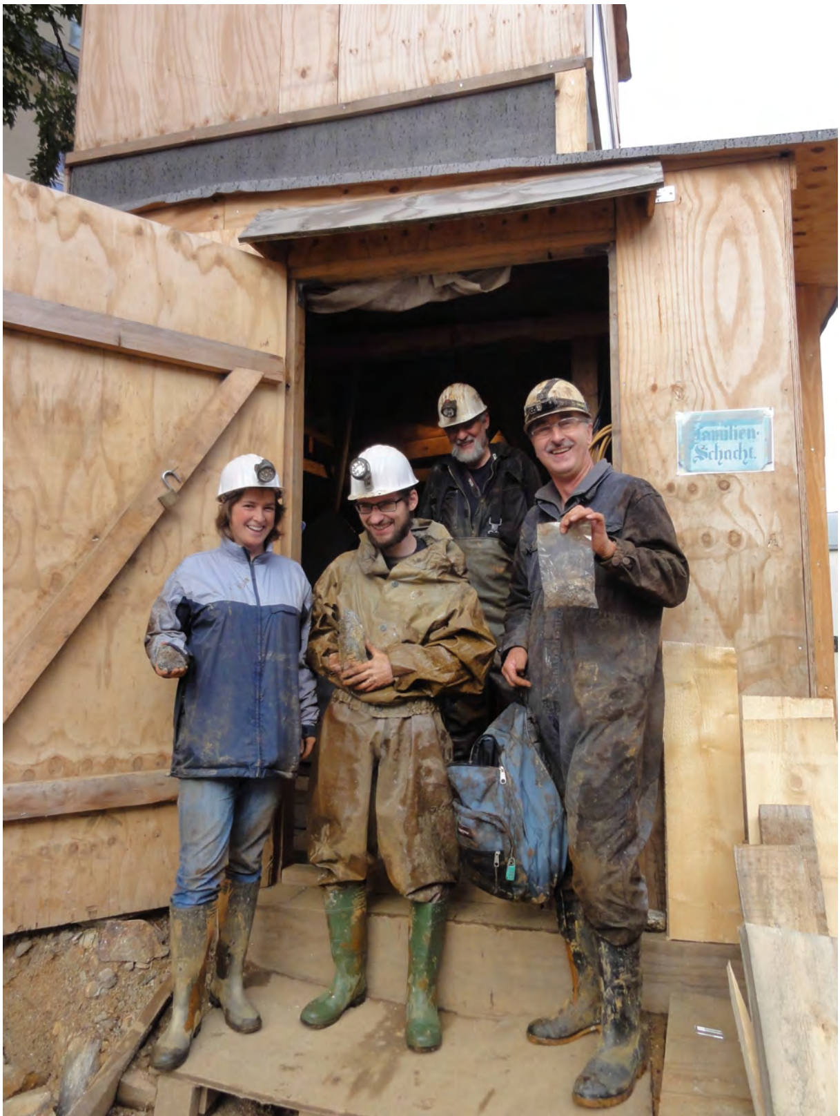
Auf den Spuren Alexander von Humboldts am 19.09. v.l.n.r.: Kristin Kehrer, Michael Gäbelein und Reinhard Kleeberg, im Hintergrund Volkmar Scholz (Sächsisches Oberbergamt), Schachtausgang der Sanierungsbaustelle Familienschacht neben dem Werner-Bau
