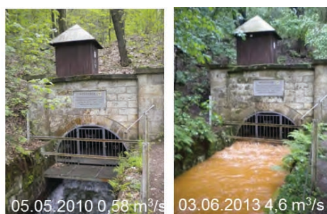
Oben: Rösche des Rothschnöberger Stollns bei mittlerem Wasserstand und Hochwasserstand
