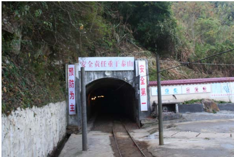
Hauptstollen der Uran-Lagerstätte Xiazhang, Provinz Jiangxi, VR China. Abbau hydrothermaler gangförmiger Uran-Vererzungen; an 300 bis 140 Ma alte Granite gebunden. Foto: TS 12/2008
