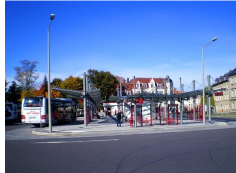
Zentraler Busbahnhof Freiberg, Wernerplatz / Roter Weg
