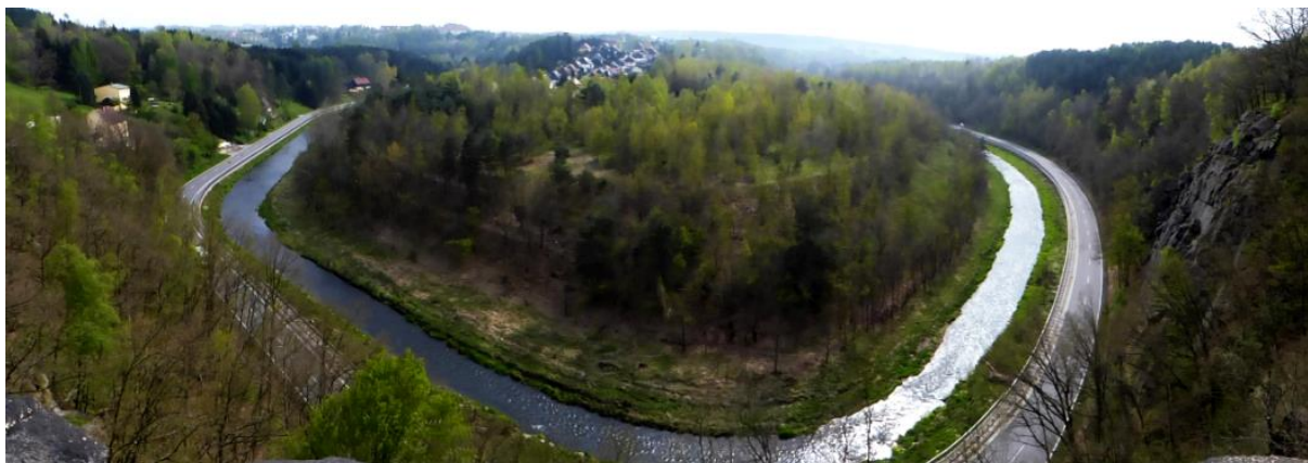
Abb. 2: Blick auf die Spülhalde VII. Lichtloch vom nordöstlich gelegenen „Kreuzfelsen“ (Foto: K. Meyer, 03.05.2017).
