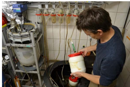
Versuchsanlage zur Biogasgewinnung im IWTT
