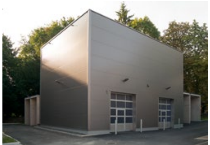
Abb. 7 (rechts): Neubau der Lagerhalle im Gebäudekomplex Tagebautechnikum
