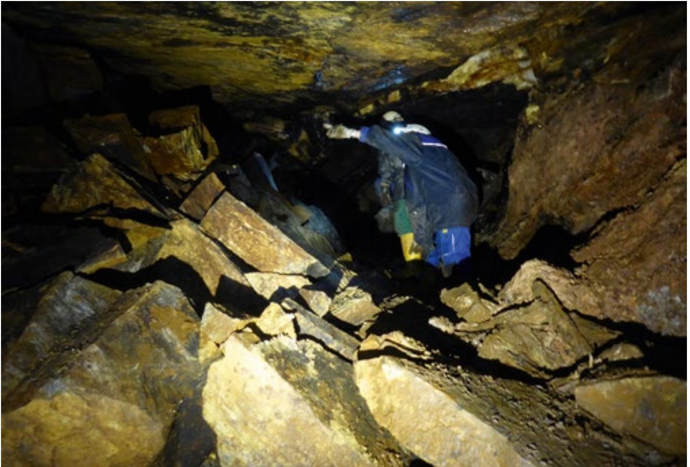
Abb. 4: Abbauhohlräume mit Verbruch auf dem Niveau Esel Stolln im Einmündungsbereich Meissner Gasse
