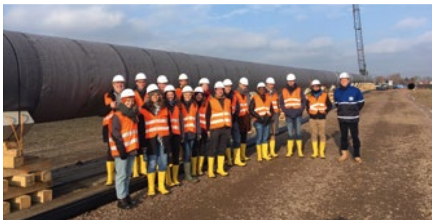
Besichtigung der EUGAL-Baustelle an der Elbe mit Studenten der TU Bergakademie (im Hintergrund das Gasrohr für den Düker)
