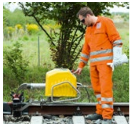
Abb. 13: Neues Brennermodul – Gesamtansicht (li.) und Einsatz im Gleis (re.)
