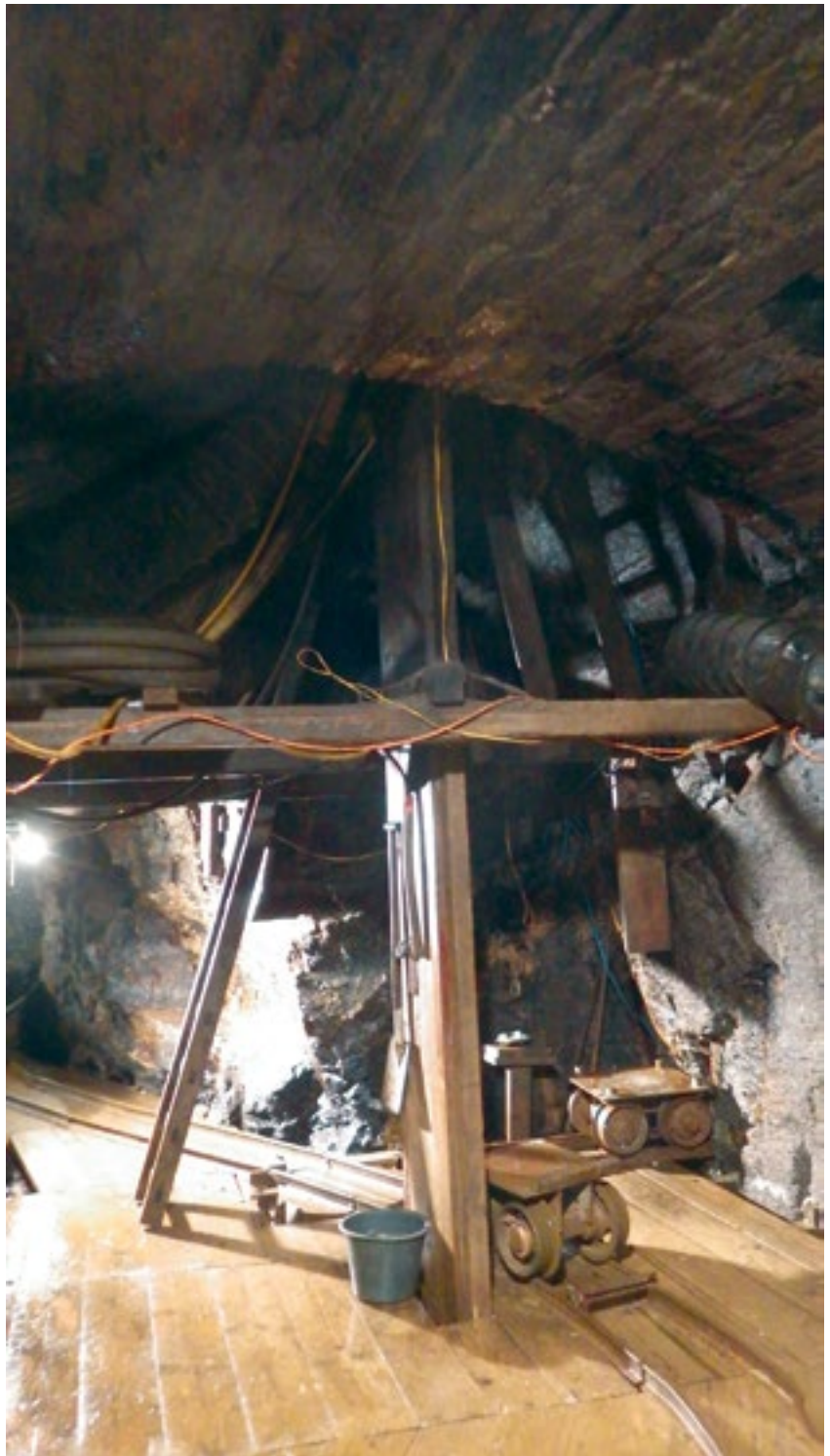
Abb. 3: Füllort Familienschacht auf dem Niveau Esel Stolln während der Sanierungsarbeiten
