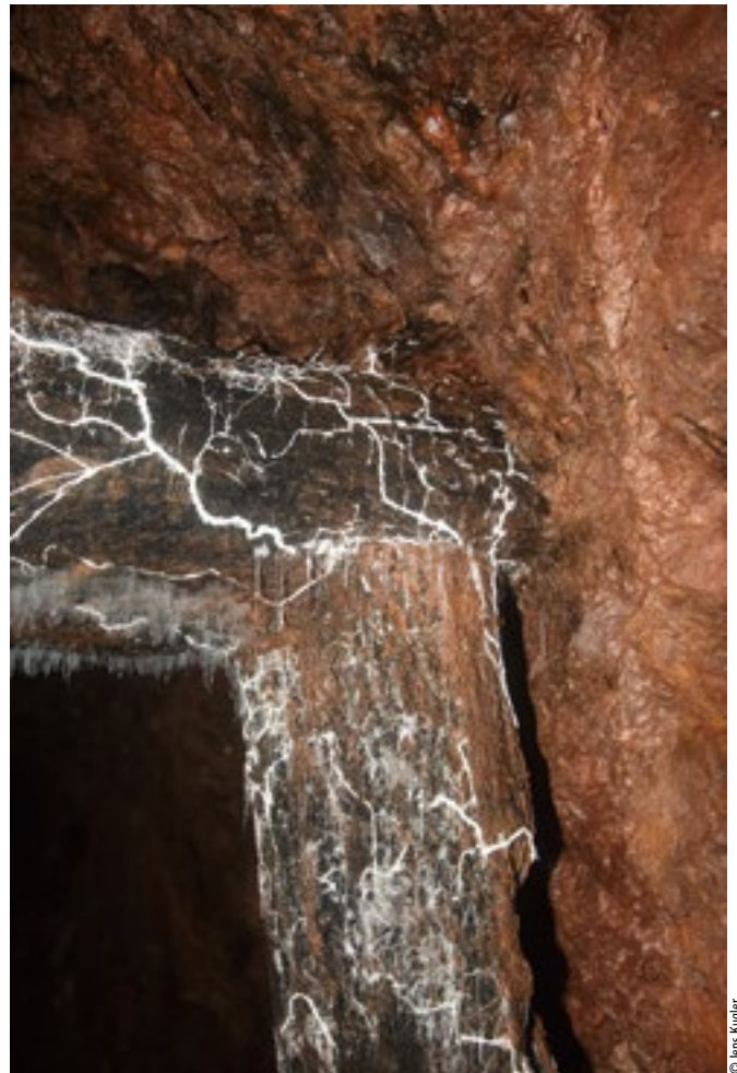
Abb. 1: Deutscher Türstock mit Pilzen am Streckenabzweig zum Jehmlich-Schacht, Churprinz Friedrich August Erbstolln, Großschirma
