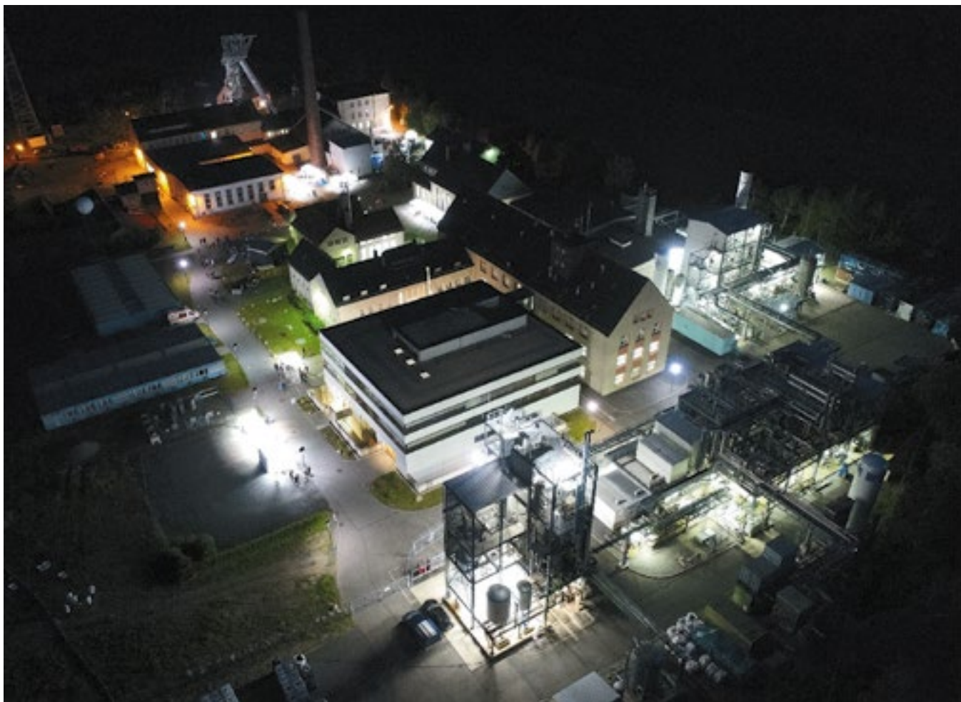
Abb. 4: Institutsstandort Reiche Zeche mit dem DBI-Gebäude und den Versuchsanlagen BGL, HP-POX und STF (2019)
