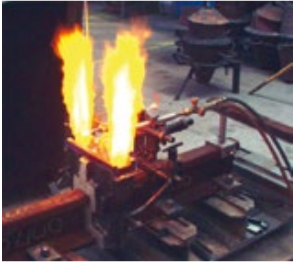
Abb. 9: Vorwärmung mit klassischem Brenner (Sauerstoff-Propan)
