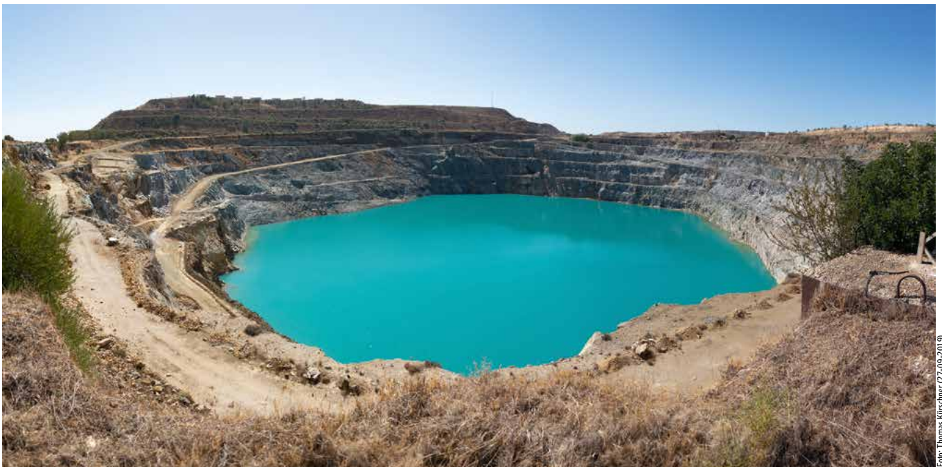
Abb. 9: Auflässiger Tagebau im Bereich der polymetallischen Cu-Zn-Pb-VMS-Lagerstätte Los Frailes/Spanien – geringmächtige Überdeckung der Lagerstätte durch tertiäre Sedimente. Explorationsobjekt der Firma GrupoMexico in Aznalcollar.
