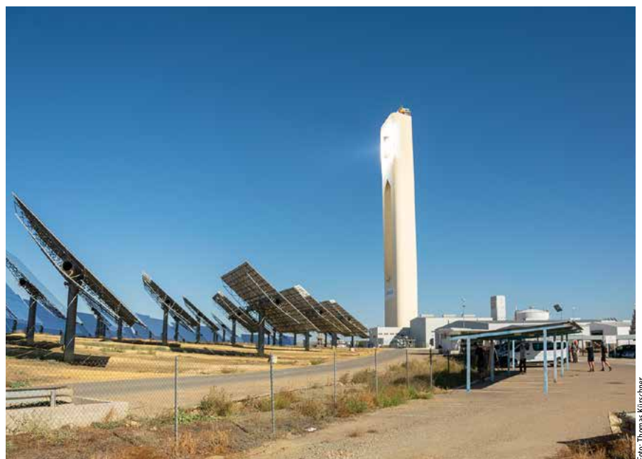
Abb. 15: Sonnen-Turm PS 10 mit einer Leistung von 10 MW, Solarturmkraftwerk im Gebiet Sanlúcar la Mayor in der Nähe von Sevilla. Ein zweiter Turm, PS 20, hat eine Leistung von 20 MW.
