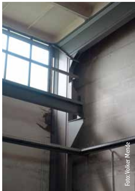
Abb. 4: Eckverband einer Halle im Industriegebiet Halsbrücker Straße mit Rahmen „Plauen II“
