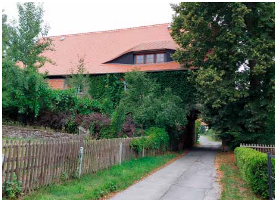
Toreinfahrt zum ehemaligen Rittergut in Kleinwaltersdorf, Zustand 24. August 2022
