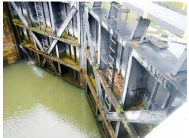
Abb. 1: Links: Verteilung der 245 Wehranlagen im Bestand der Wasserstraßen- und Schifffahrtsverwaltung (WSV) des Bundes in den vier Zustandsnotenbereichen (Quelle: Schmidt-Bäumler 2020). Rechts: Durch Korrosion und Dauerbelastung beschädigtes Schleusentor (Quelle: BAW 2015)
