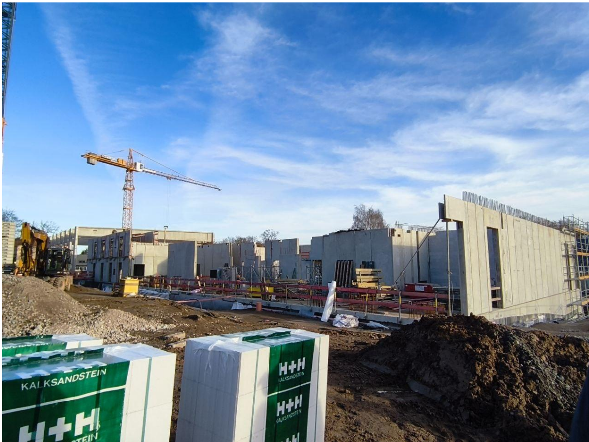
Abb. 1: Rohbauarbeiten im Dezember 2025 am Zentralen Sächsischen Bohrkernarchiv in Freiberg. Foto: Christin Kehrer.
