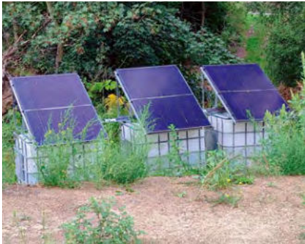
Abb. 4: Aufbau der Pilotanlage: PV-Module und Speicher-IBC (links) sowie Verfahrensstufen Travertinfilter, Zwischenspeicher, Vertical Flow Bioreaktor (VFBR) und Pflanzenbecken (rechts) (Fotos: E. Janneck)
