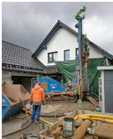
Abb. 1: Oberflächennahe Geothermiebohrungen in Gebäudenähe (linkes Foto aus /Stü-25/)
