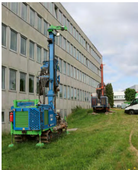
Abb. 1: Oberflächennahe Geothermiebohrungen in Gebäudenähe (linkes Foto aus /Stü-25/)
