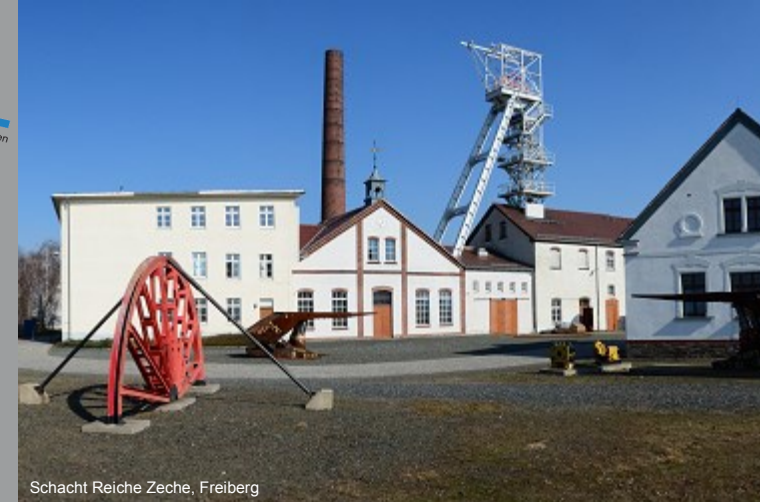
Schacht Reiche Zeche, Freiberg
