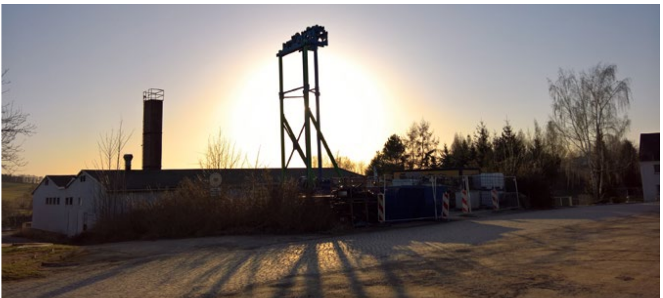
Abbildung 5: EIV-Bohranlage E-RIG auf dem Gelände von Homilius Bohren und Umwelttechnik in Naundorf
