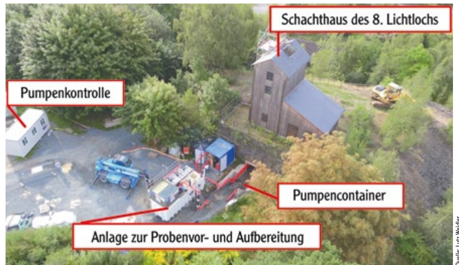
Abbildung 3: Übertägige Versuchsanlagen mit Anschluss an das untertägige Leitungssystem
