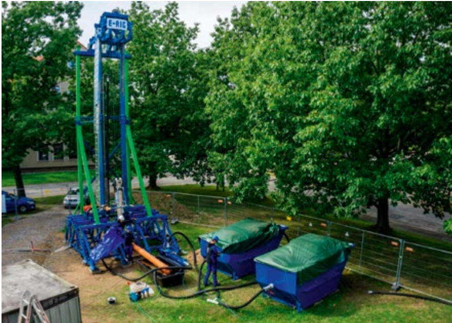
Abbildung 4: EIV-Bohranlage E-RIG auf dem Campus der TU Bergakademie Freiberg
