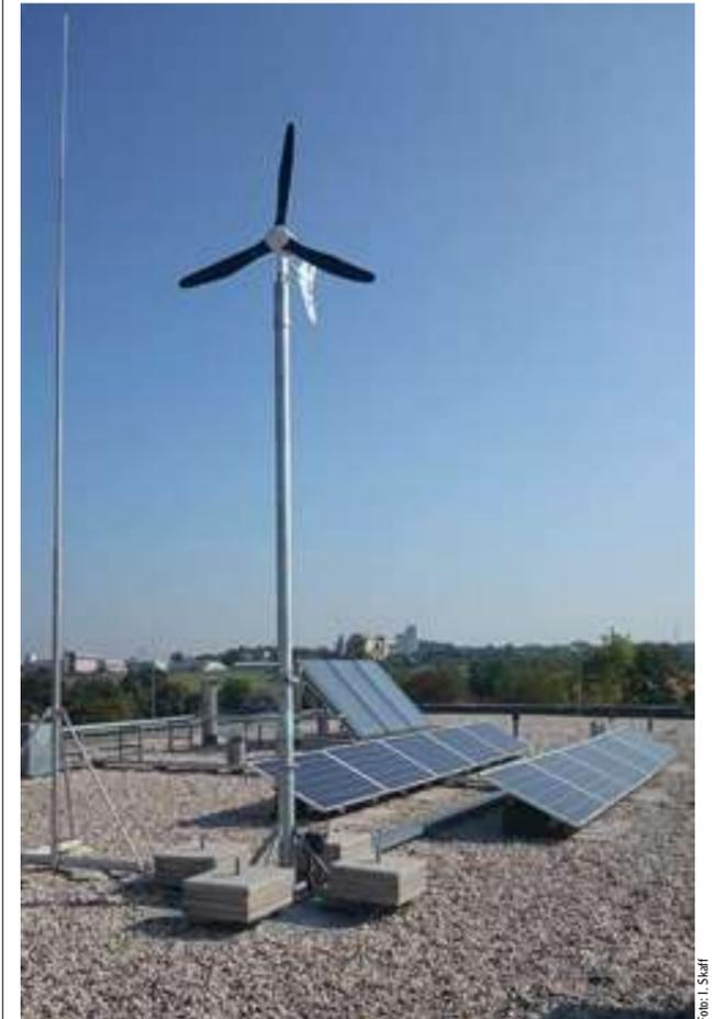
Abb. 4: Die Dachebene der TMV-Halle mit Windgenerator (Vordergrund), dahinter die PV-Anlage, hinten links die Solarthermieanlage (ganz im Hintergrund ist das DBI-Gebäude zu sehen)
