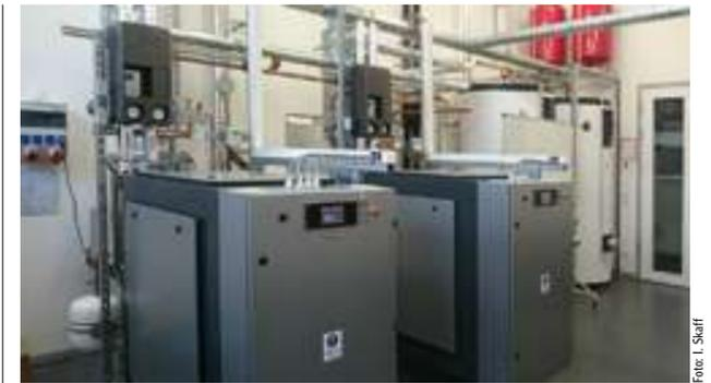
Abb. 3: Die beiden „Viessmann“-MBHKW, im Hintergrund die beiden 1000L-Pufferspeicher
