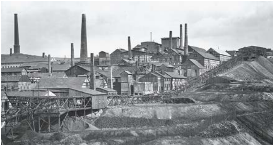
Die Schwefelsäurefabrik wurde von der großen Bleikammeranlage dominiert. Hier fand aber auch die Anhydridproduktion nach dem Kontaktverfahren ihr Unterkommen. Aufnahme 1927, Sammlung Kolmschlag
