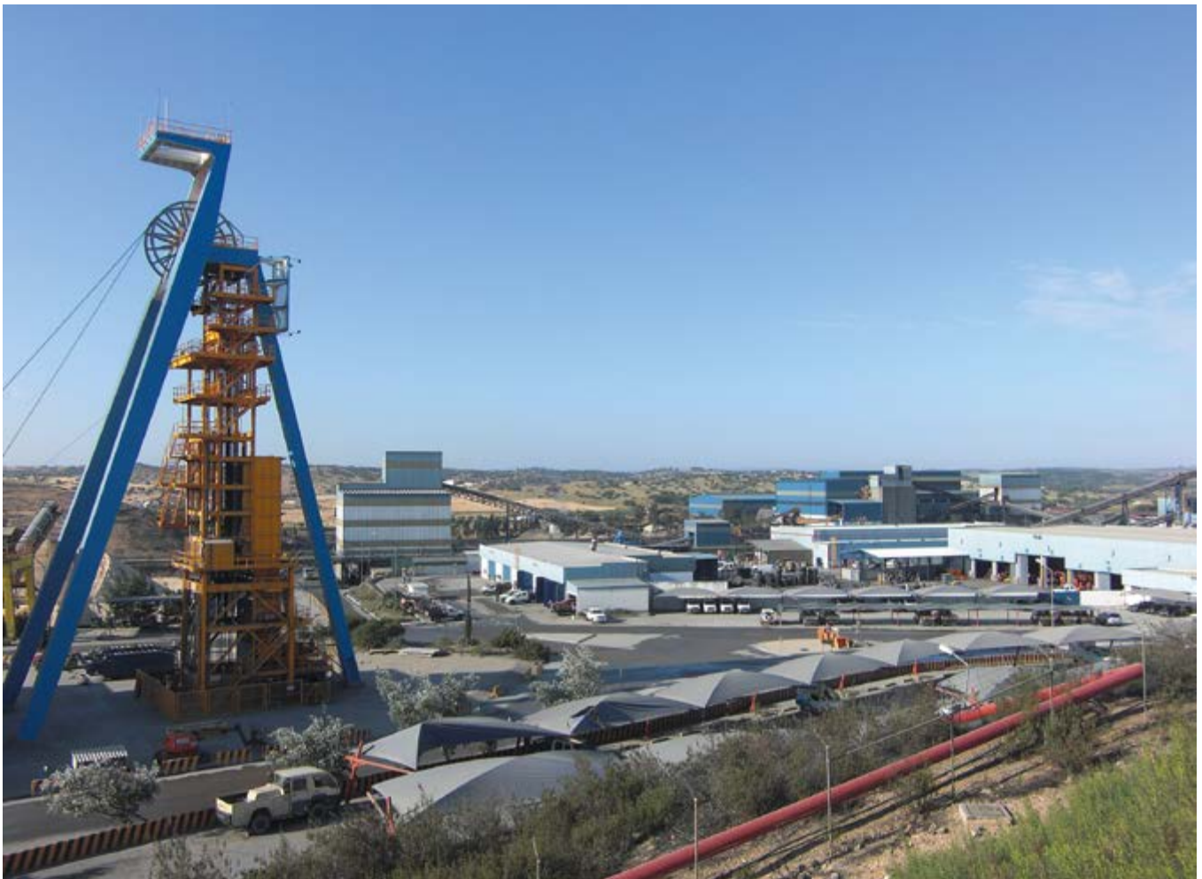
Abb. 2: Die Übertageanlagen des Bergwerks Neves Corvo in Portugal: St. Barbara Schacht und Förderturm (l.), Aufbereitungsanlagen (hinterer Bildteil) und Fuhrpark
