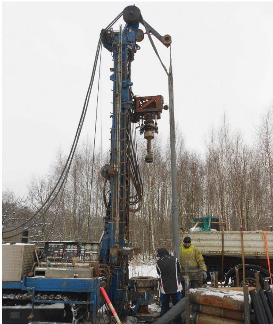
Abb. 1: Bohrwagen der Bohrgesellschaft Roßla mbH während der ersten Bohrkampagne auf der Spülhalde Münzbachtal. Bei dem angewendeten Bohrverfahren handelt es sich um Rammkernbohrungen mit PVC-Linern.
