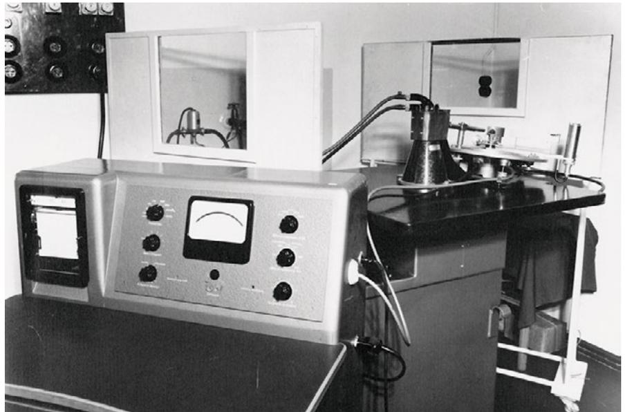
Abb. 5: Zählrohrgoniometer nach Berthold und Isodebyeflex-Generator (Fa. Seifert) im Institut für Mineralogie (1959)
