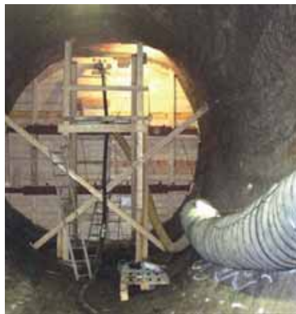
Abb. 2: Untertägige Entwicklungsarbeiten zum MgO-Dammbau im Kalisalz (Carnallit) der Grube Teuschenthal im Rahmen des Projektes „CARLA“
