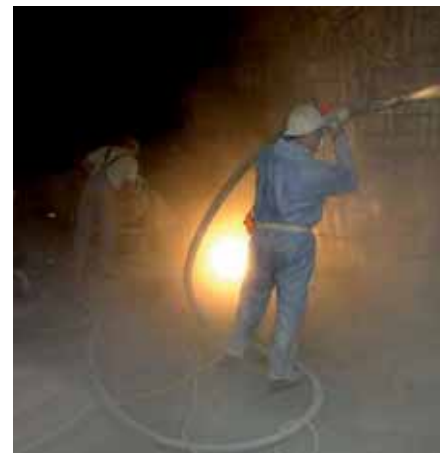
Abb. 2: Untertägige Entwicklungsarbeiten zum MgO-Dammbau im Kalisalz (Carnallit) der Grube Teuschenthal im Rahmen des Projektes „CARLA“
