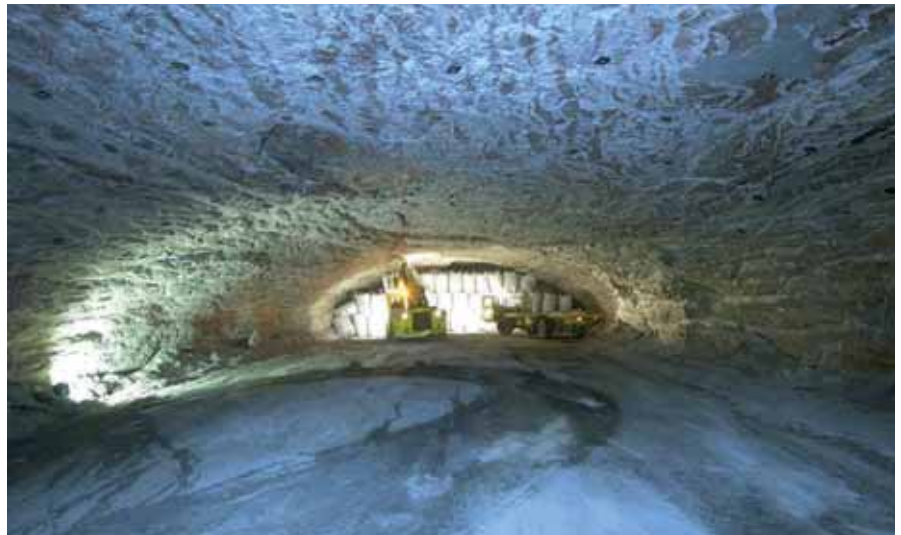
Abb. 1: Versatz von Hohlraum in der Kalisalzgrube Teuschenthal
