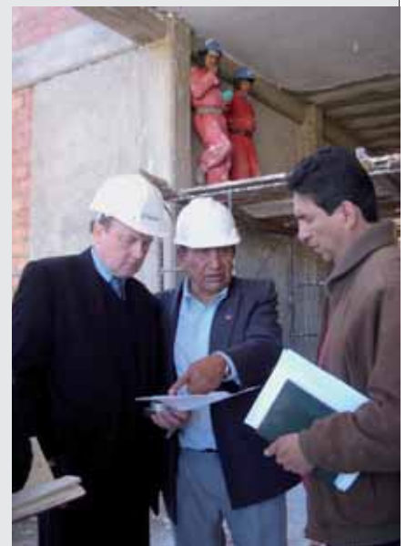
Prof. Wolfgang Voigt (l.) und Dr. Jaime Claros (m.) vor dem Rohbau des neuen Technikums in Potosí
