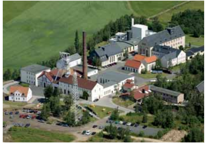
Schachanlage „Reiche Zeche“. Foto: Jens Kugler
