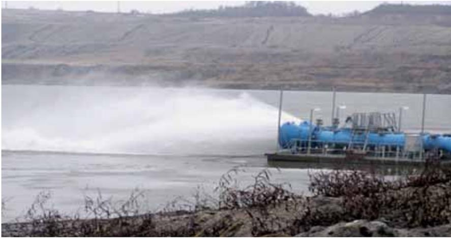
Abb. 5.1: Auslauf vom schwimmenden Ponton aus. Foto P. Radke
