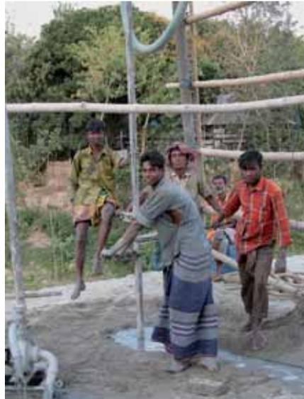
Abb. 3b: Manuelles Rotary-Bohren
