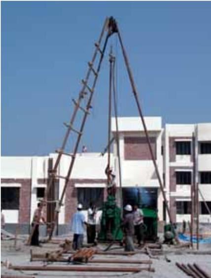
Abb. 3a: Maschinelle Kernbohrung
