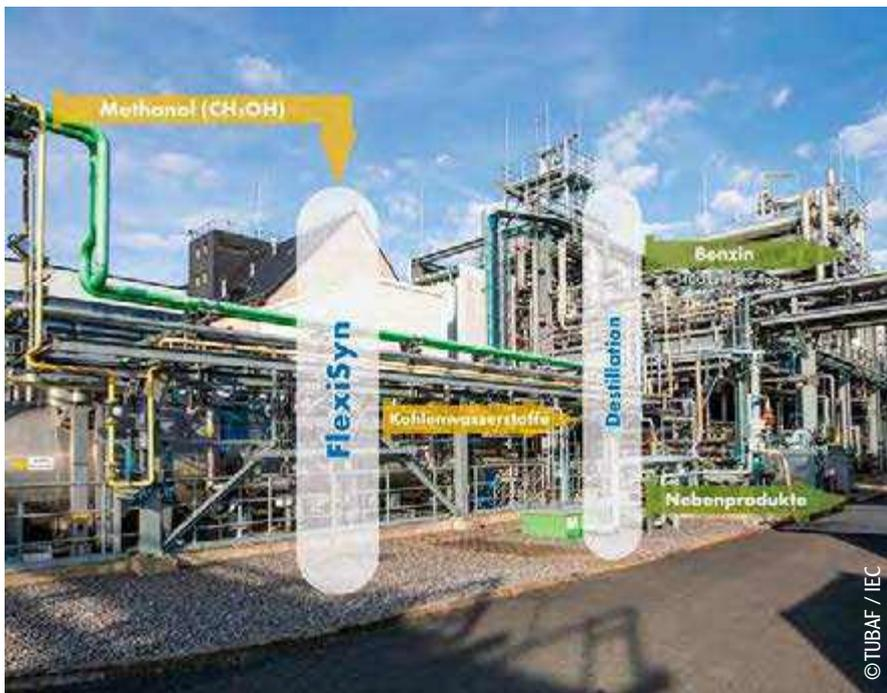
Abb. 1: Schematische Darstellung des Methanol-to-Gasoline-Prozesses an der Benzinsynthese-Großversuchsanlage der TUBAF
