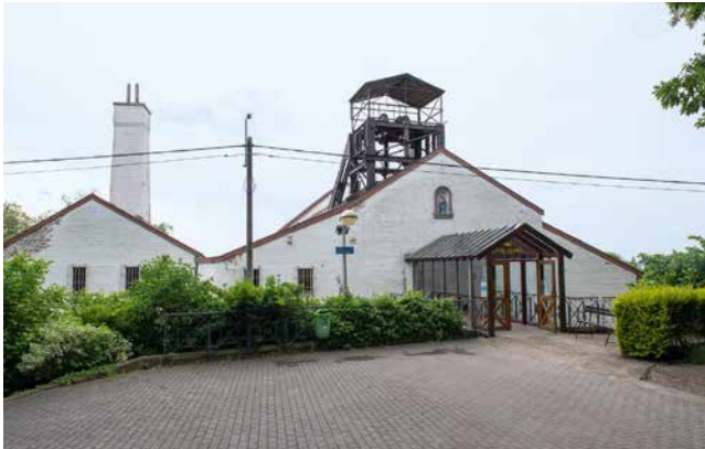
Fig. 7: Blegny-Mine – the Puits-Marie
