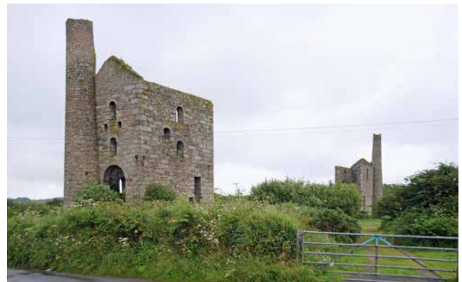
Abb. 8: Cornwall und West Devon, Maschinenhäuser, Großbritannien
