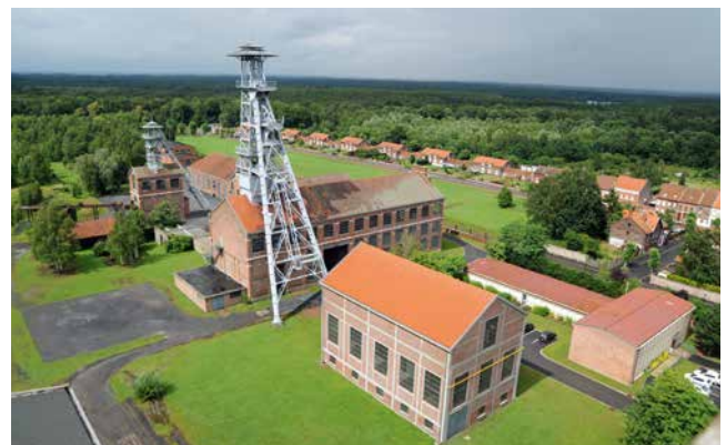
Abb. 9: Grube Wallers Arenberg in Nord-Pas-de-Calais, Frankreich
