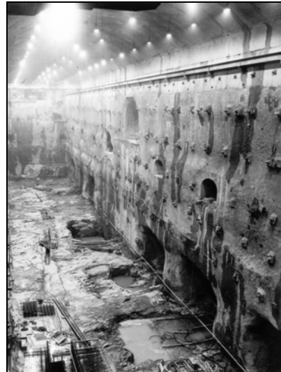
Kaverne des Pumpspeicherkraftwerkes Markersbach
