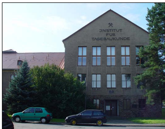
Institutsgebäude Geotechnik; heute „Helmut – Härtig – Bau“
