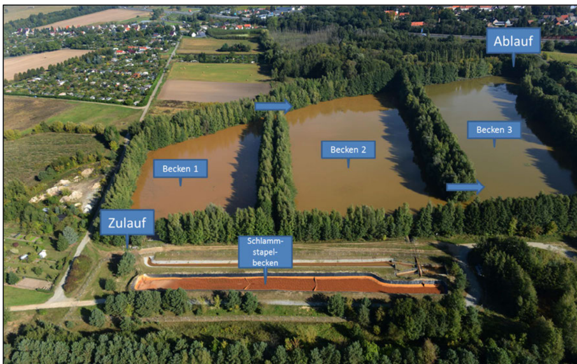
Abb. 6: Wasserbehandlungsanlage in der ehemaligen GWRA Vetschau
