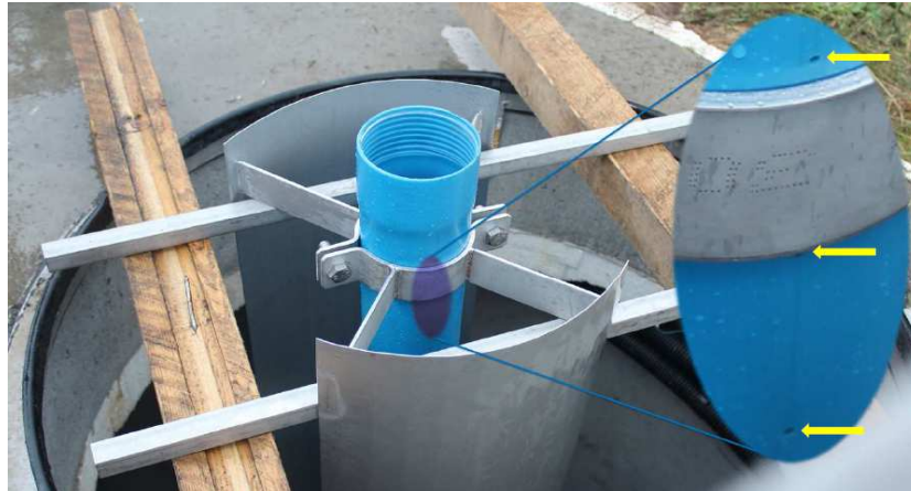
Abb. 8: Einbau des Multiportdiffusors mit Detaildarstellung der Austrittsöffnungen
